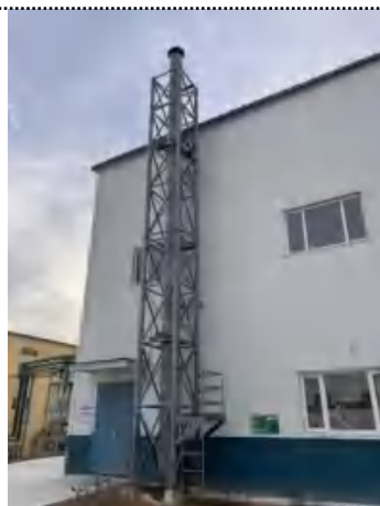
原料车间排气筒
