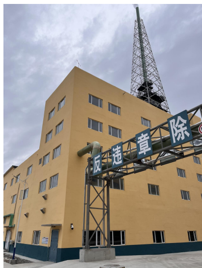
回转窑废气排气筒（高 60m）
