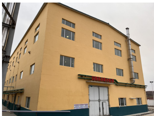
沉铜及废水处理站
