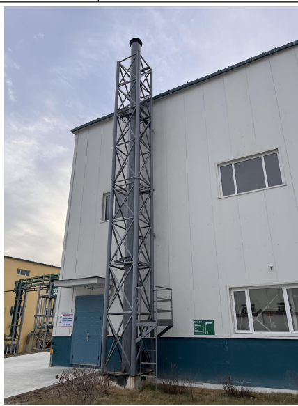
原料车间排气筒
