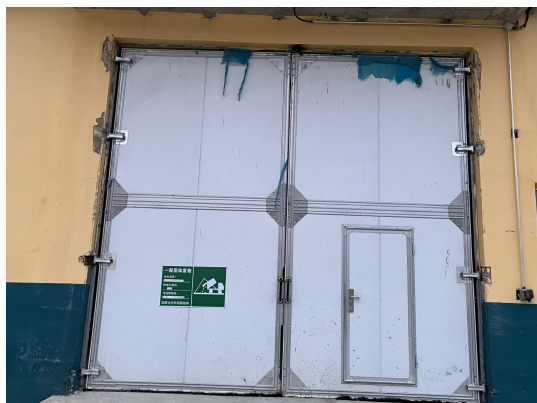
脱硫石膏库房
