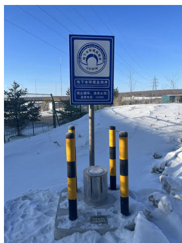
地下水扩散监测井
